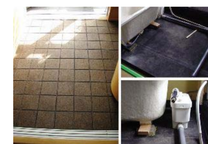
写真5 インフィル対応防水パンシステム
